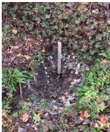
Clapet complètement ensasé (vue côté terre)
